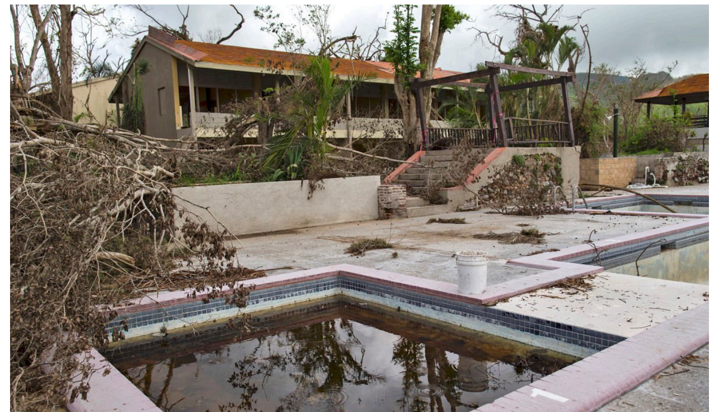
Ilustración 14. Imagen del Hotel Baños de Coamo tras el impacto del huracán María
