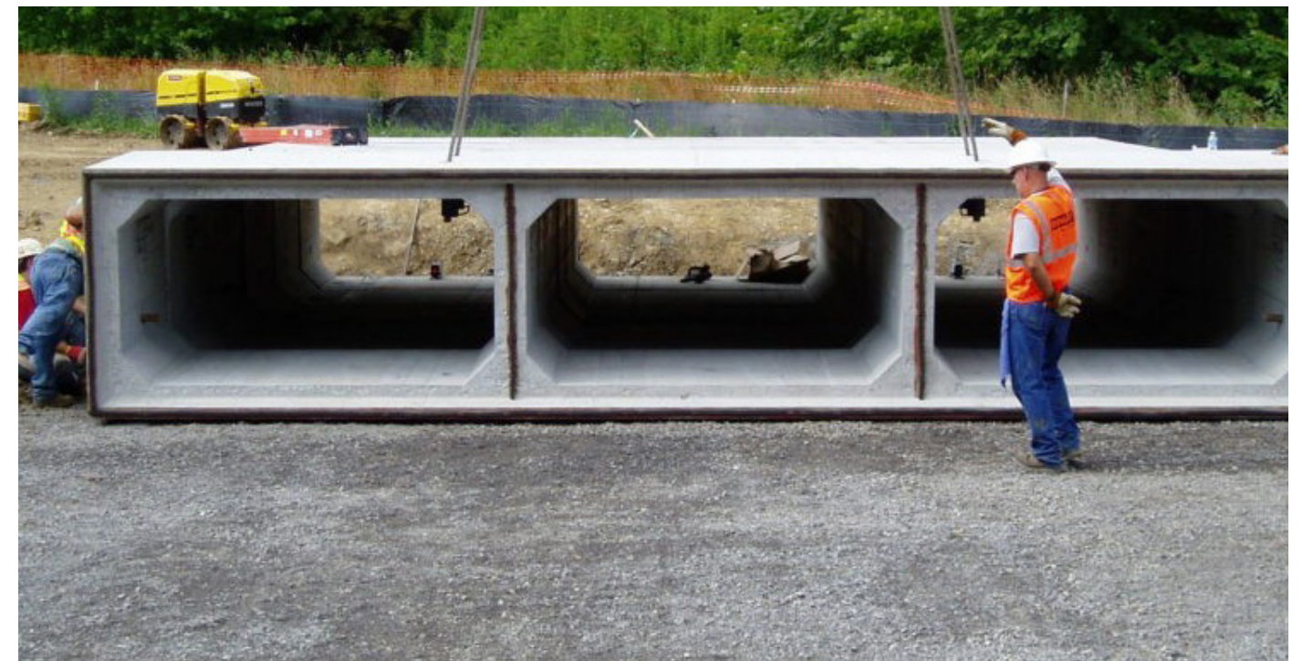
Ilustración 46. Modelo de un puente tipo “box culvert”
