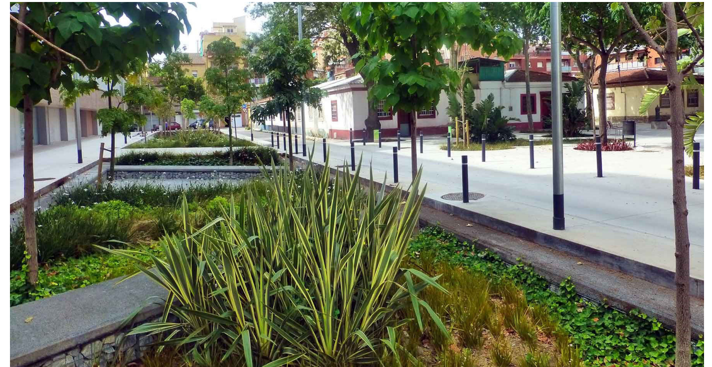
Ilustración 45. Ejemplo de manejo sostenible de escorrentías mediante un jardín de lluvia (rain garden) en un área urbana.
