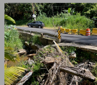
Puente vado en el barrio Cañaboncito. Foto de ATCS (abril 2023)
