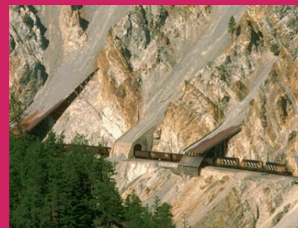
Túneles para proteger vías
