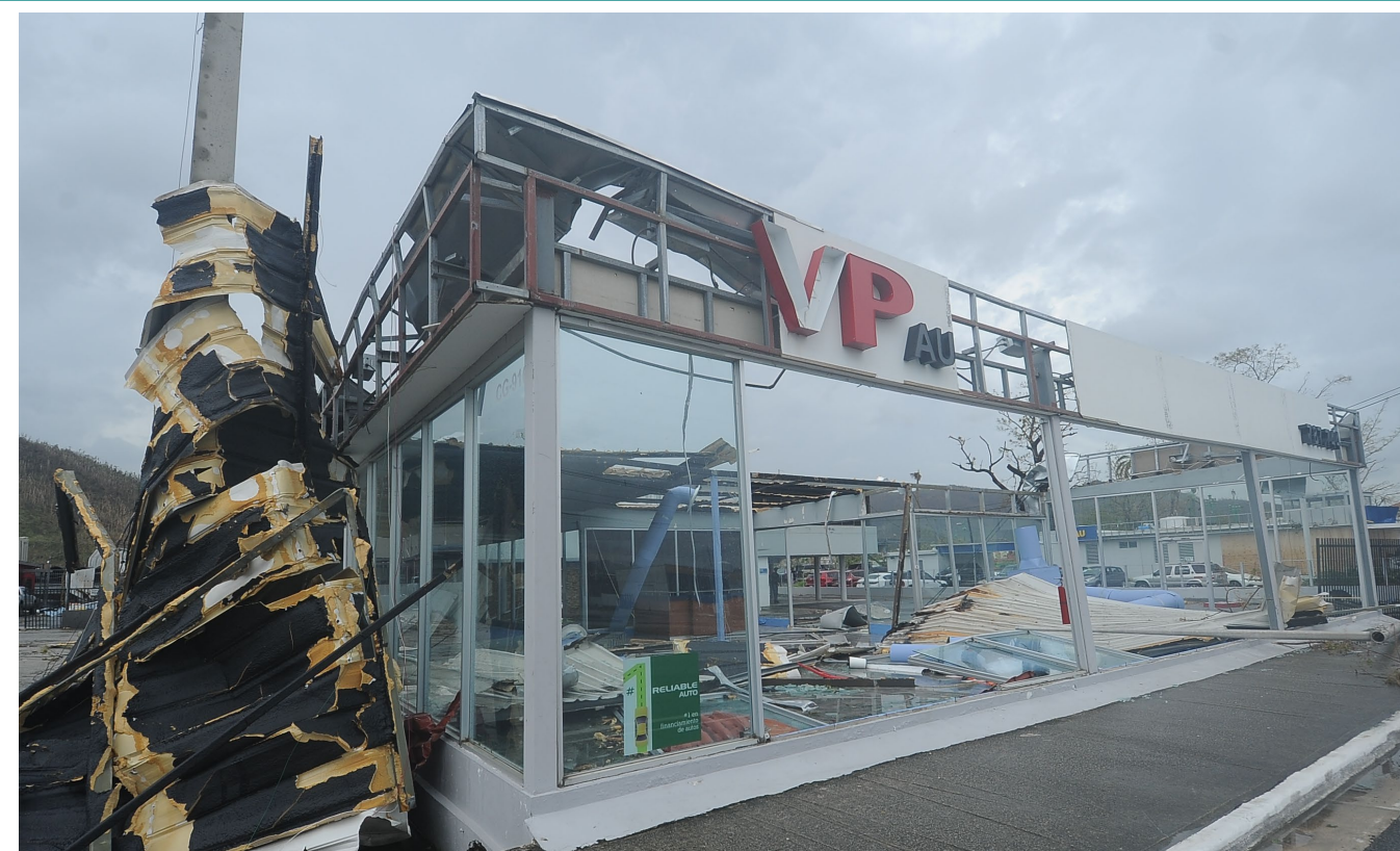
Propiedad comercial destruida por el huracán María. Foto del Municipio (septiembre 2017)
