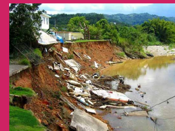
Erosión de meandro en el río Turabo
