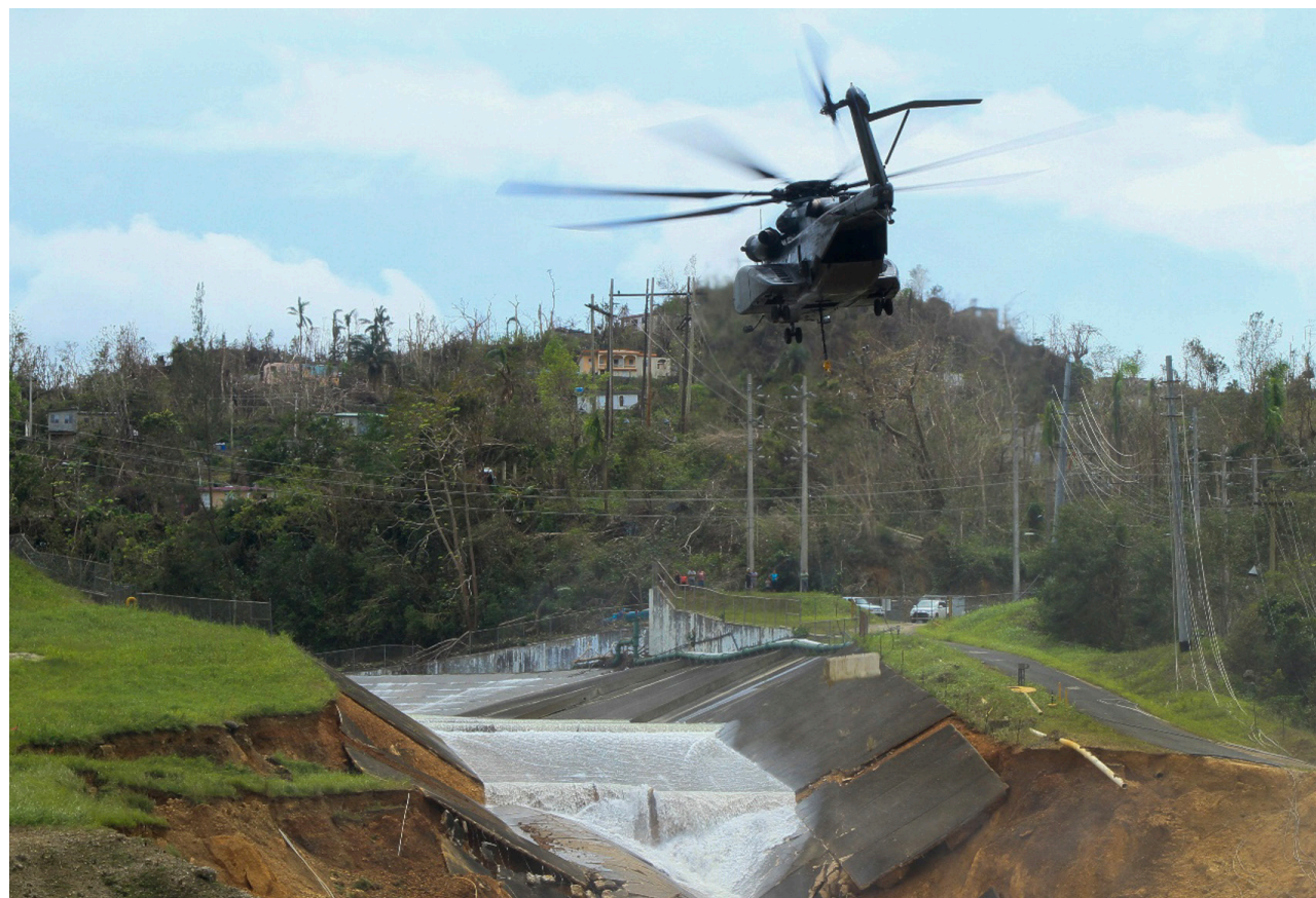
Ilustración 27: Un helicóptero MH53 de la Marina coloca una barrera para fortalecer la presa rota, el 5 de octubre de 2017 en la presa Guajataca, Isabela, Puerto Rico.
